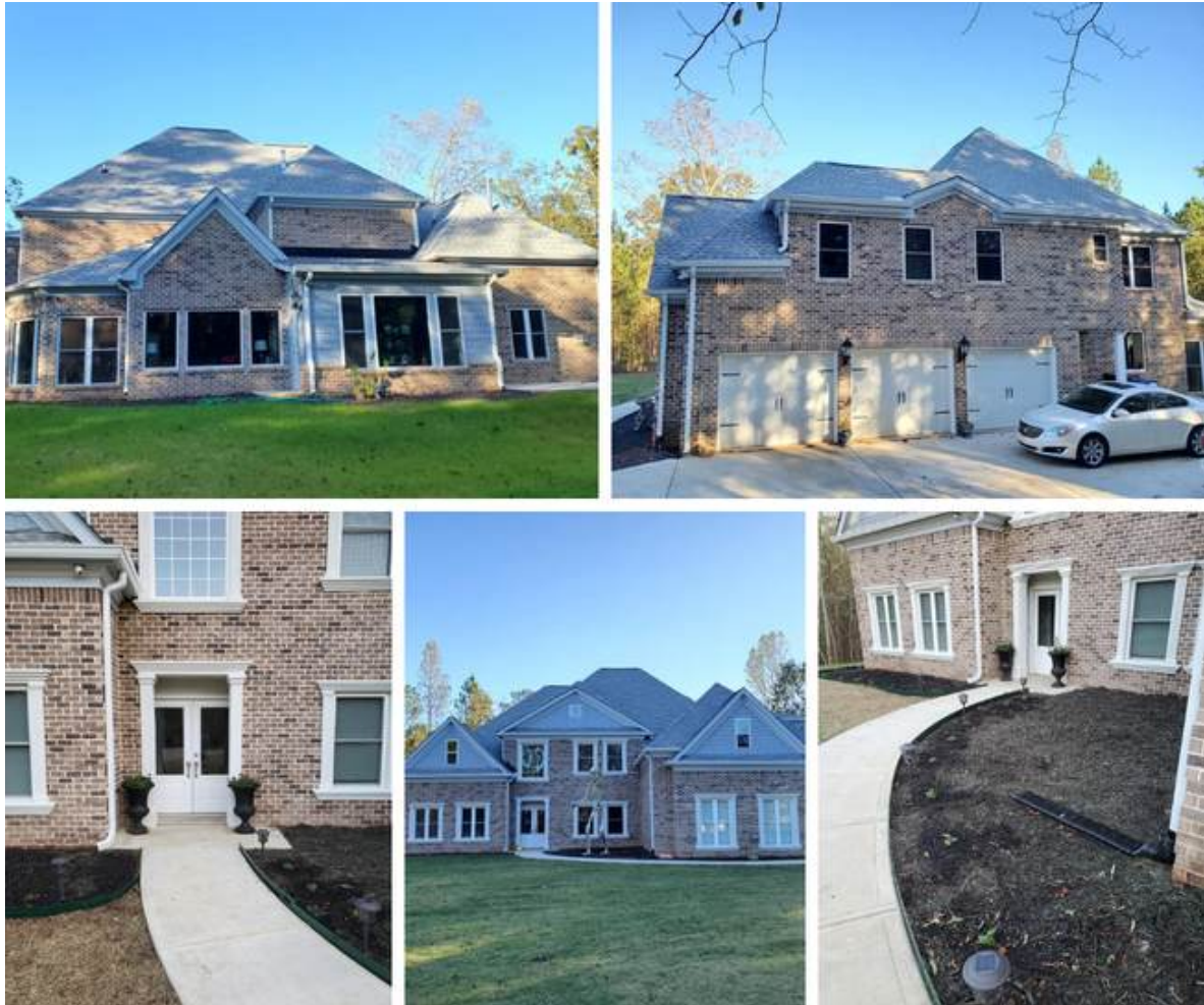
Esterno della villa Zulock: retro (in alto a sinistra), garage per tre auto (in alto a destra), porta d'ingresso (in basso a sinistra), davanti (in basso al centro) e percorso verso l'ingresso (in basso a destra)
