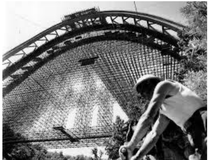
Domus: viadotto dell'Autostrada del Sole in costruzione
