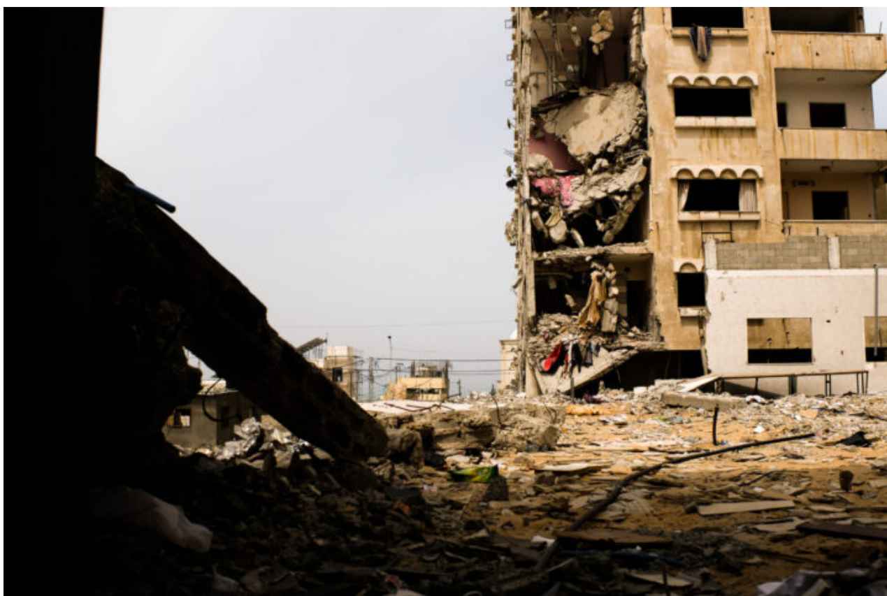
Un altro angolo della torre residenziale abbandonata.
