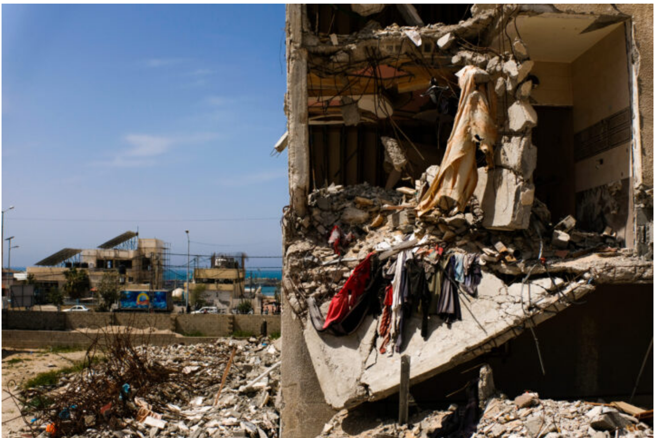
Un edificio residenziale è abbandonato dopo aver subito gravi danni irreparabili durante il bombardamento della torre Hanadi, nell’ultima offensiva israeliana a Gaza a maggio del 2021.
