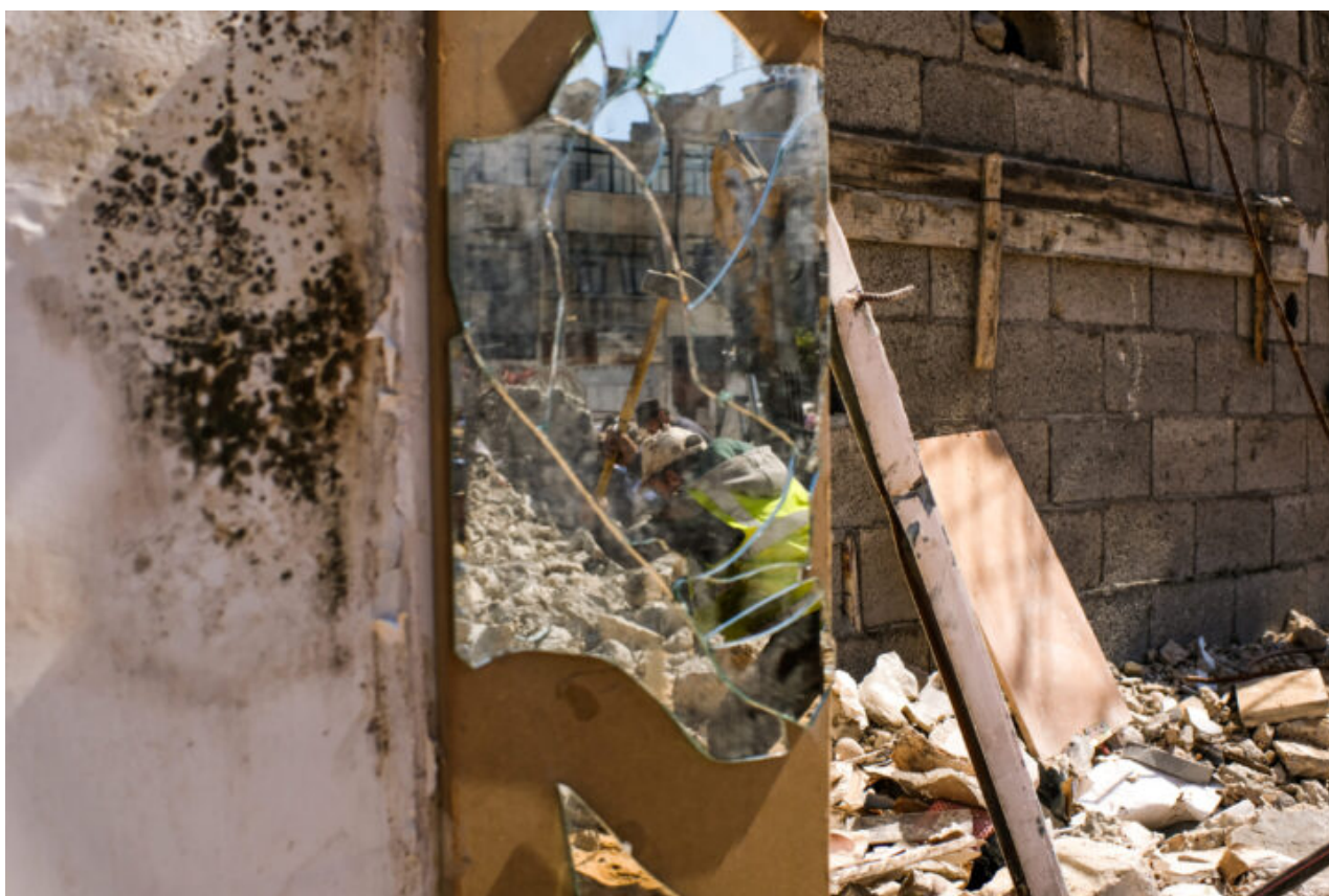
Un operaio usa una mazza per separare l'acciaio dal cemento dalle macerie della torre al-Shorouq, ad al-Rimal, Gaza.
