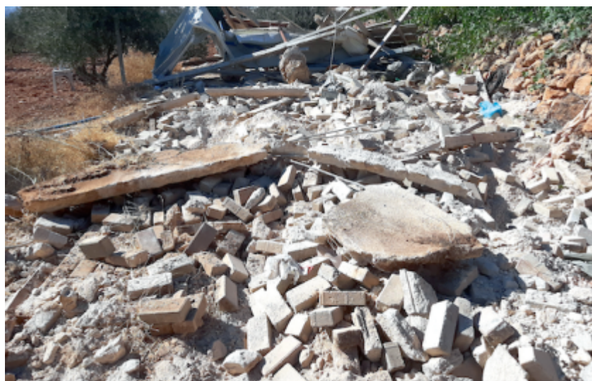
Demolizione di una struttura agricola
