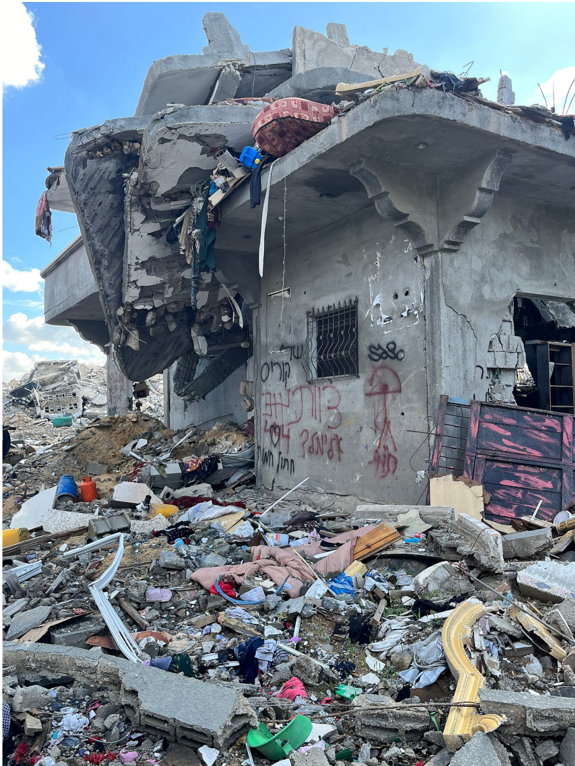
Un edificio parzialmente distrutto in un quartiere spopolato di Beit Hanoun. 1 febbraio 2024. (Foto di Jonathan Whittall.)
