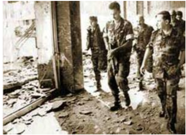
1989. Il generale Aoun, a destra, nel palazzo danneggiato.
