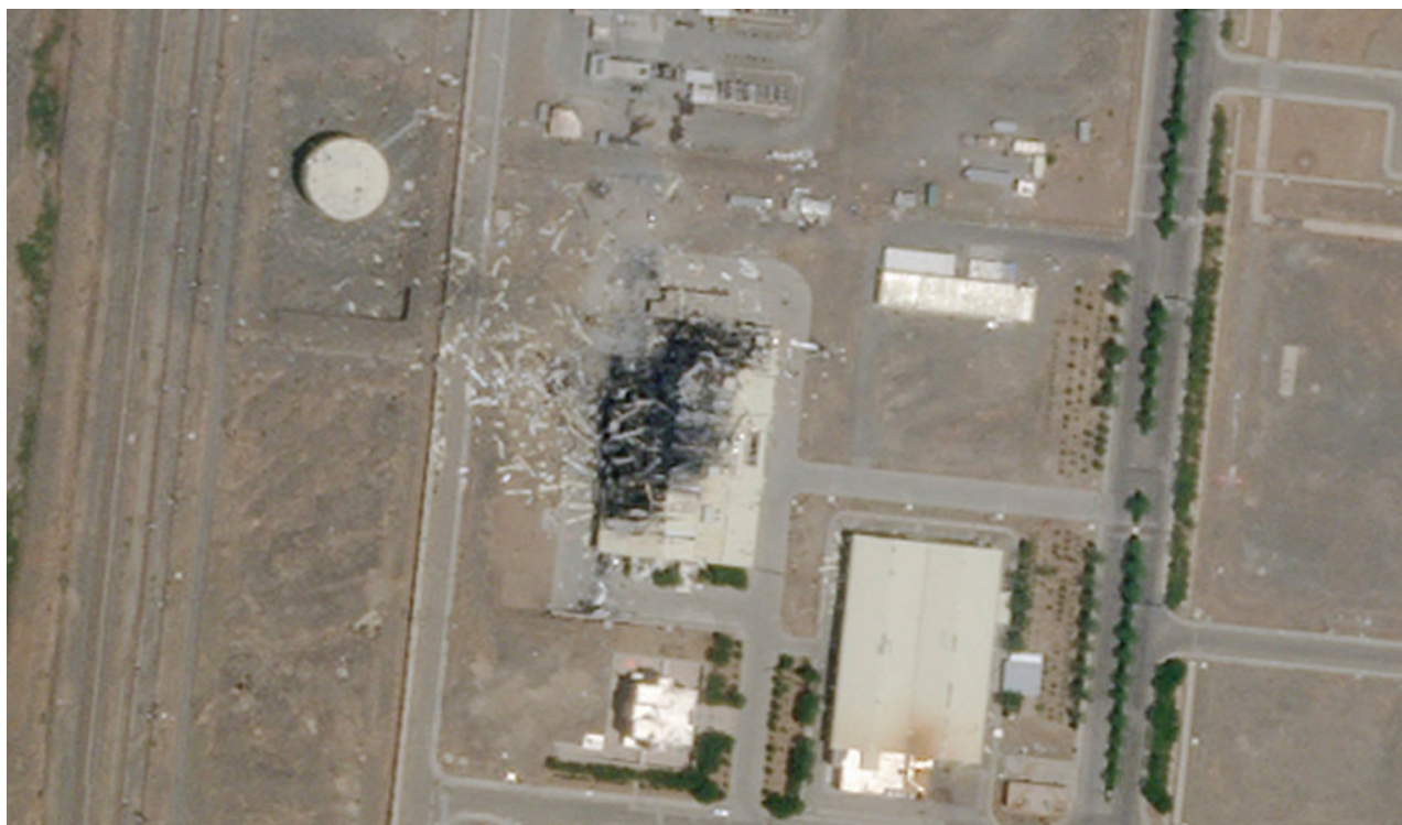
La foto satellitare mostra i danni all'avanzato impianto di assemblaggio di centrifughe presso il sito nucleare di Natanz.
