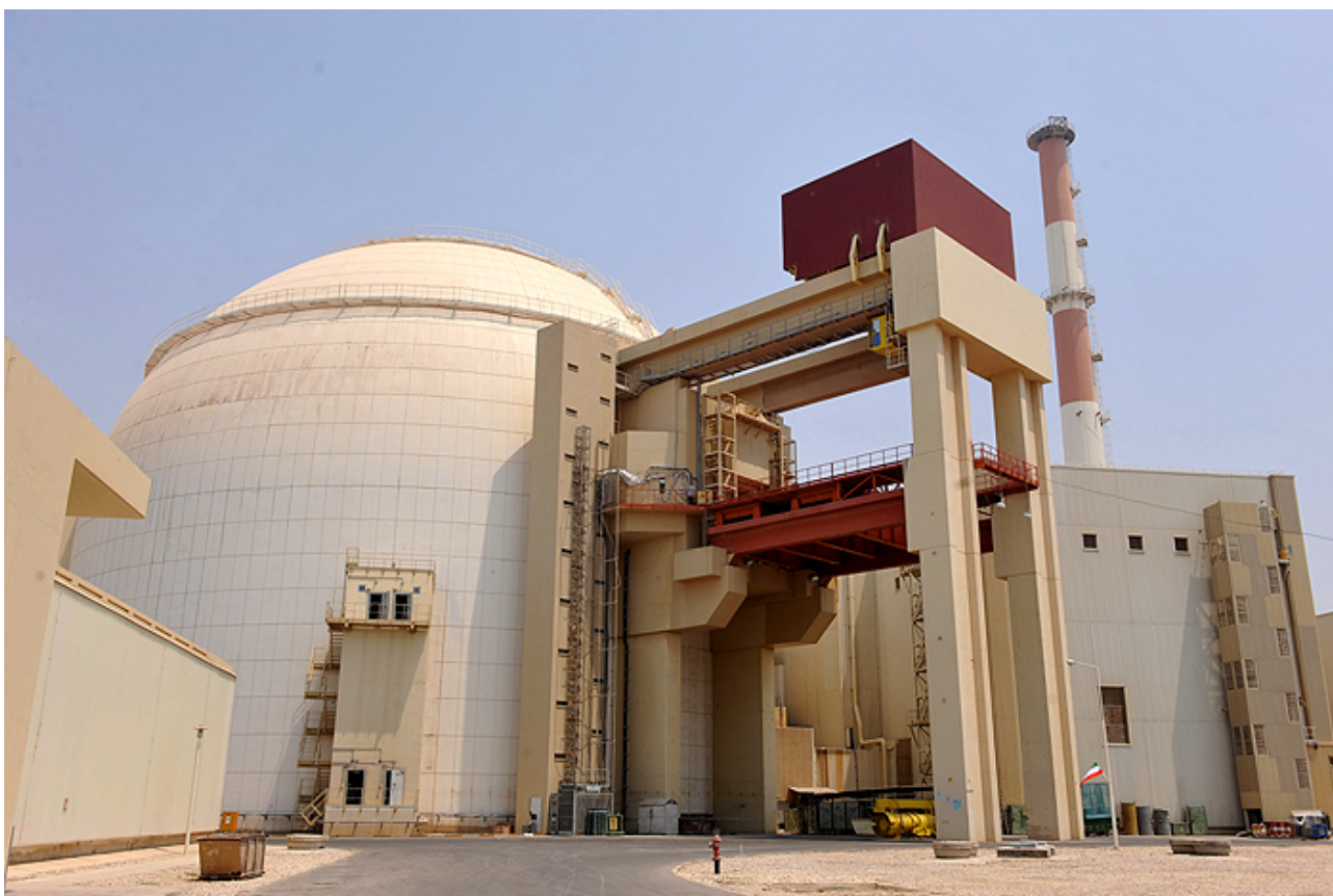
Veduta dell'edificio del reattore presso la centrale nucleare di Bushehr, costruita dai russi, durante il primo caricamento di combustibile, il 21 agosto 2010 a Bushehr, nel sud dell'Iran. © Getty Images / IIPA via Getty Images
