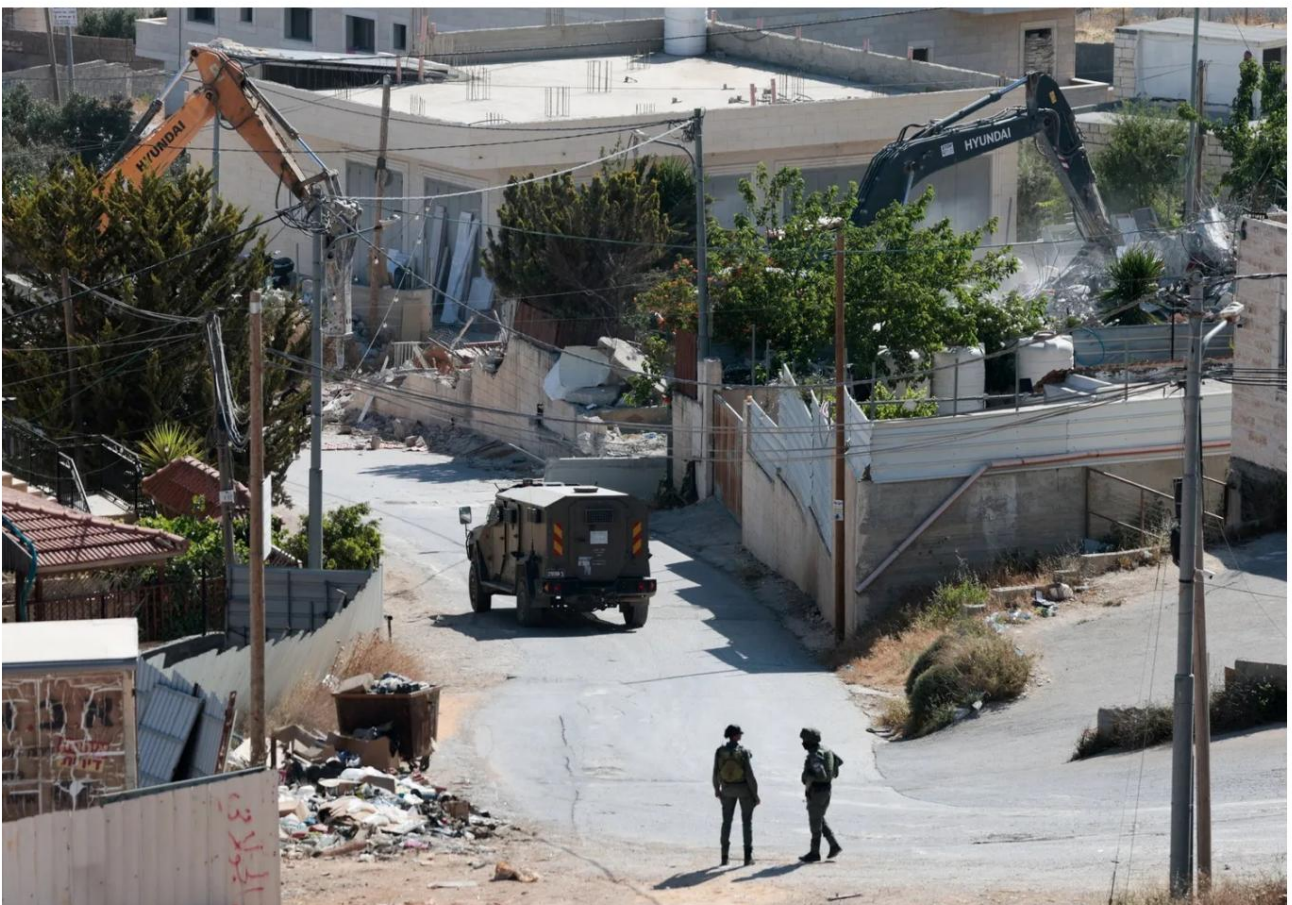
Gli escavatori militari israeliani demoliscono un edificio palestinese nella città di
