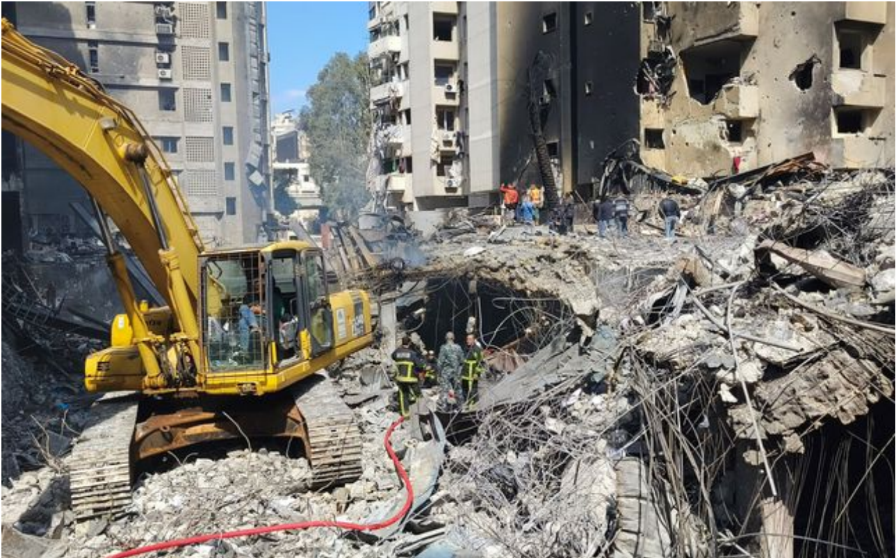
Demolizione edifici Libano
